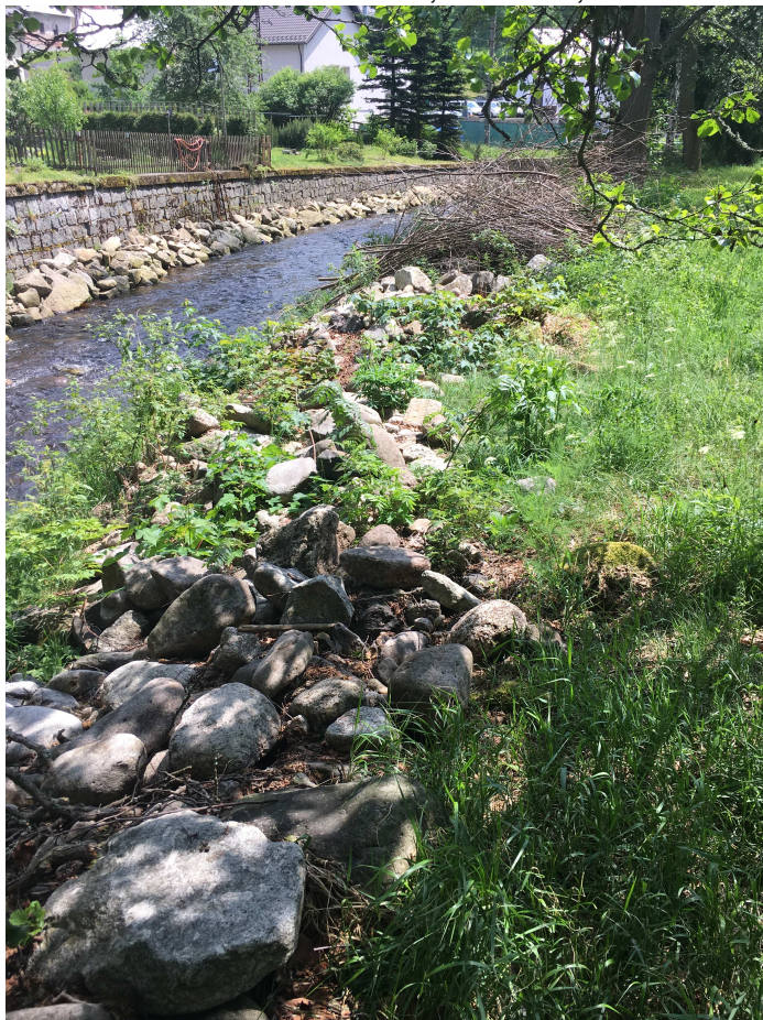
OPEVNĚNÍ PRAVÉHO BŘEHU – STANIČENÍ 0,0650 – 0,1000
